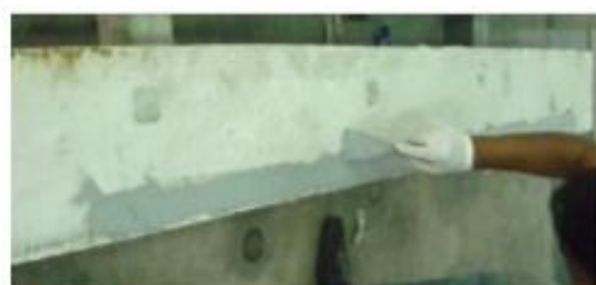
(d) After fill up the groove level the surface
