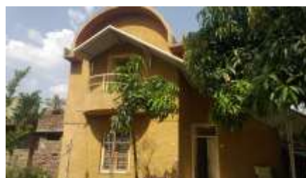
Fig. No. 2 Actual Building
